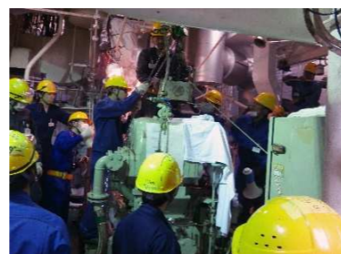
整備作業（ピストン抜き）
