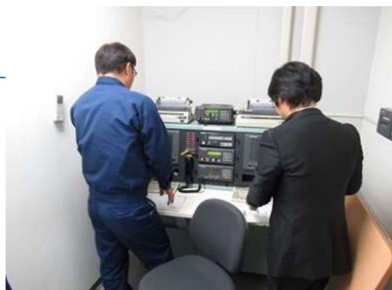
第2実習実験棟 GMDSSシミュレータ
